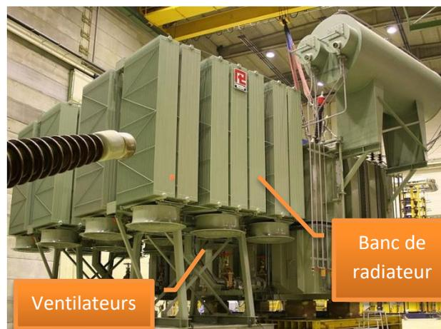
**Figure3.14.** Système de refroidissement
