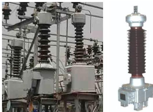
**Figure 3.27.** Transformateur de potentiel
