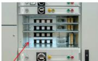
Compartment pour tiroir comprenant les volets de protection "Broches" + les borniers des contacts auxiliaires "commande".
