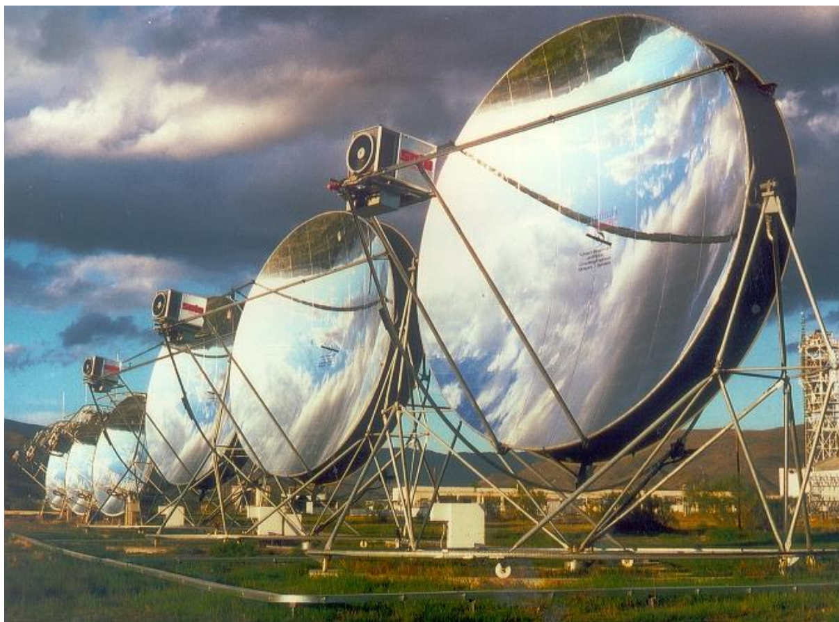
Figure 11.4 : centrale à collecteurs paraboliques
